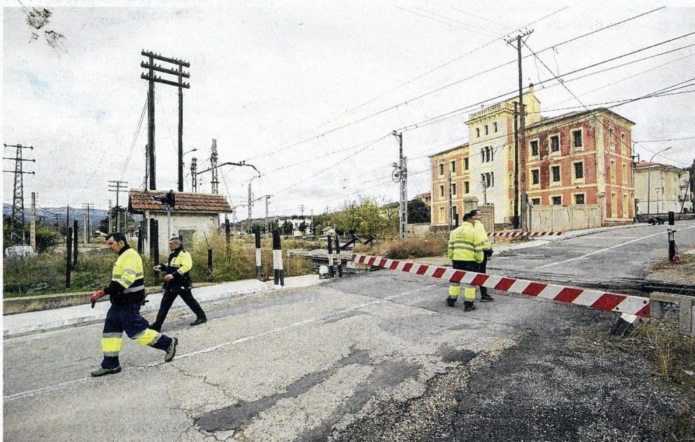
Tècnics treballant ahir al pas a nivell de Móra la Nova, després de l'accident. FOTO: JOAN REVILLAS
