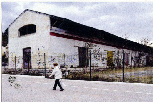
Imatge de l'antiga nau que ha de ser enderrocada. / NÚRIA CARO
