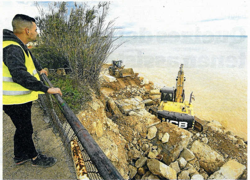
Treballs de reparació dels danys dels temporals a la costa nord d'Alcanar, ahir. FOTO: JOAN REVILLAS
