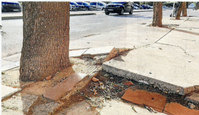
Una vorera completament aixecada per les arrels d'un arbre a Vora Parc, ahir. FOTO: JOAN REVILLAS
