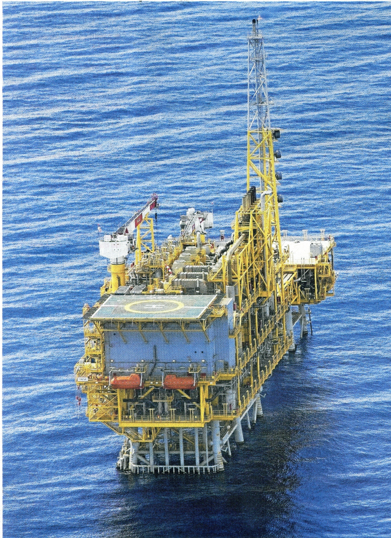
La planta marina del projecte Castor. FOTO: JOAN REVILLAS
