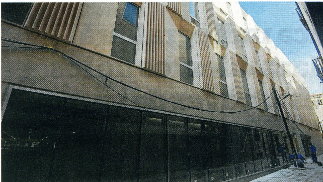
Operaris treballant en el nou Palau de Justícia, vist des de la Biblioteca Marcel·lí Domingo. FOTO: JOAN REVILLAS
