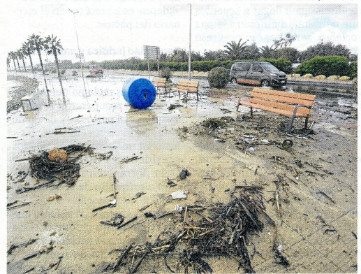
Estado del paseo marítimo de L'Ampolla, ayer. FOTO: JOAN REVILLAS
