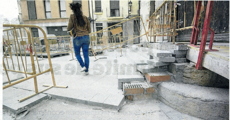
Les escales originals amb les noves de formigó a sobre. FOTO: JOAN REVILLAS
