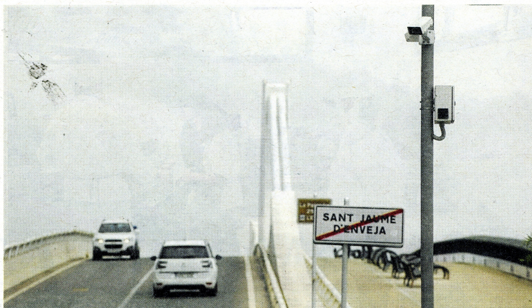
La càmera de videovigilància instal·lada al pont Lo Passador sobre l'Ebre. FOTO: JOAN REVILLAS
