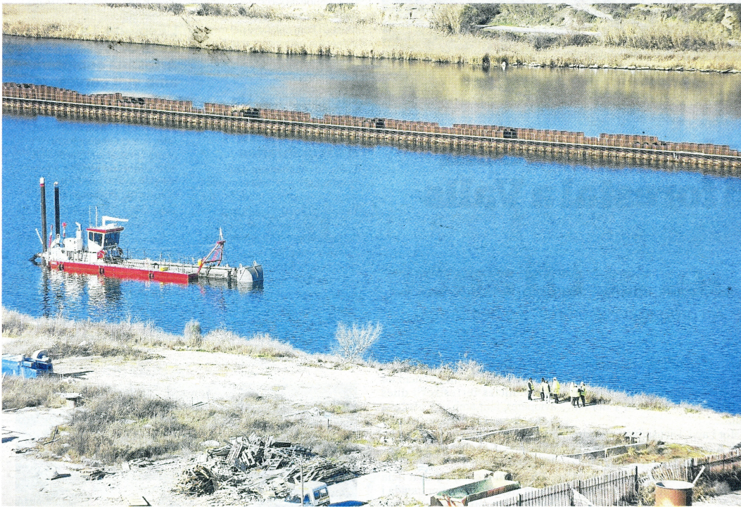
La draga, treballant en l'extracció dels llots contaminats de l'embassament. FOTO: JOAN REVILLAS
