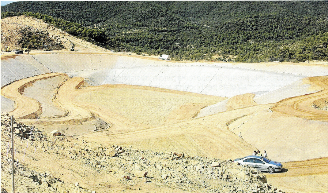
L'abocador de Ribarroja encara en fase de construcció. FOTO: JOAN REVILLAS
