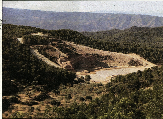
Seguixen les obres a l'abocador de Riba-roja d'Ebre.
