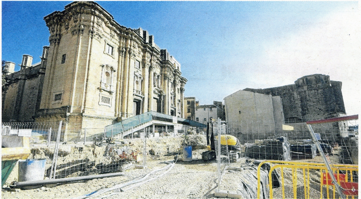
Imatge d'ahir a la tarda de les obres, on s'estan realitzant micropilotatges. FOTO: JOAN REVILLAS
