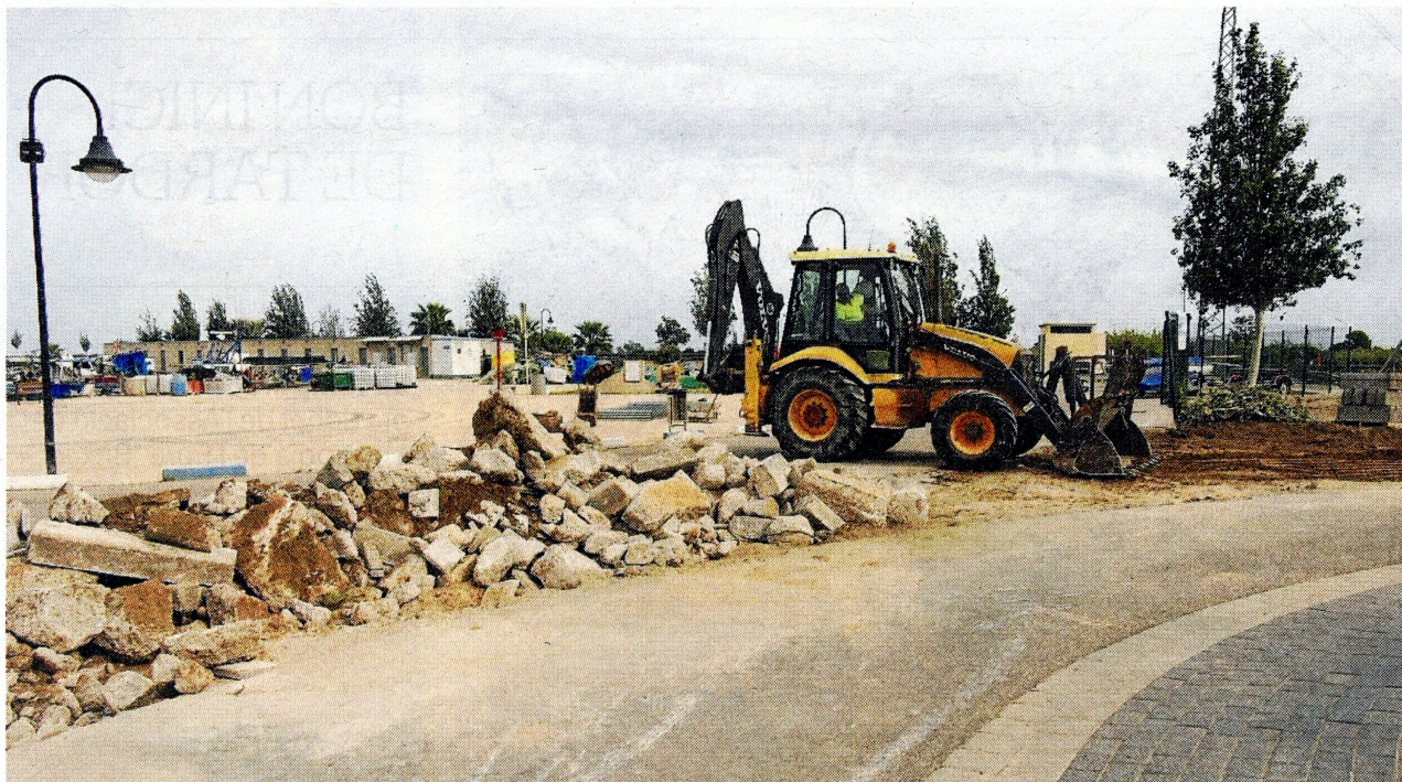
Imatge dels operaris treballant, ahir a la tarda a Deltebre. FOTO: JOAN REVILLAS
