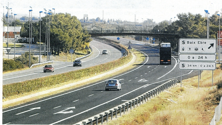
La autopista AP-7 a su paso por la comarca del Baix Ebre. FOTO: JOAN REVILLAS/DT
