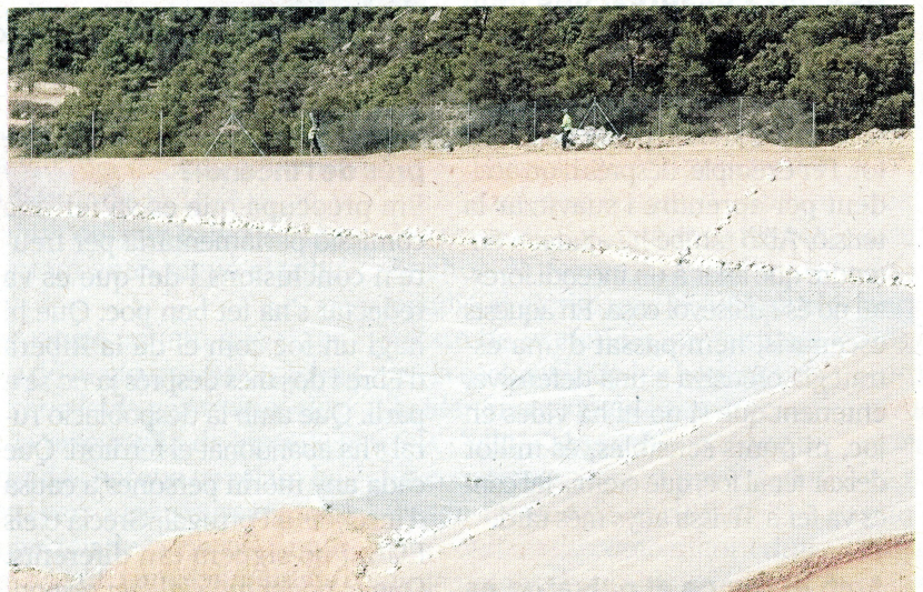
Imatge del dipòsit de residus que s'està construint a Riba-roja d'Ebre, ahir. FOTO: JOAN REVILLAS
