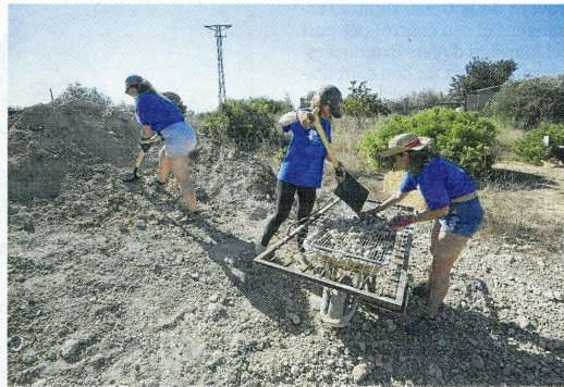
Els joves netegen de vegetació els espais per construir una bassa d'argila adjacent. FOTO: JOAN REVILLAS
