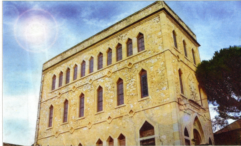
L'edifici modernista de l'antic col·legi teresià podria convertir-se en un alberg / FOTO: CEDIDA
