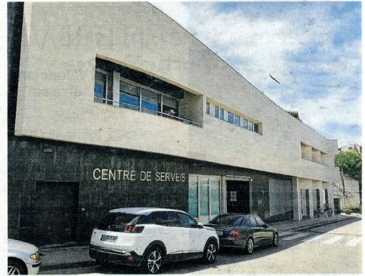
L'equipament s'instal·larà a l'actual centre de serveis. FOTO: JOAN REVILLAS
