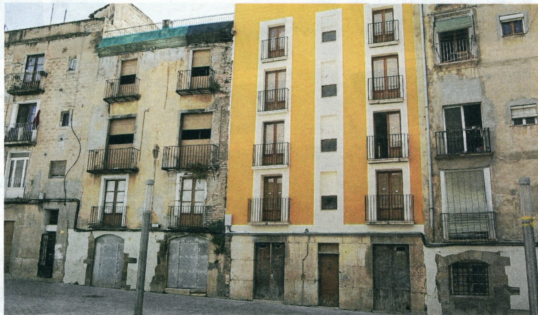
El mateix grup d'edificis amb la retirada del cablejat ja efectuada. FOTO: JOAN REVILLAS
