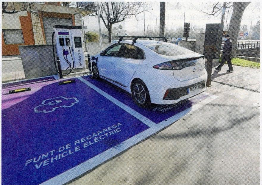
La infraestructura permet alimentar dos vehicles de manera simultània, un amb recàrrega ràpida i l'altre, semiràpida. FOTO: J. REVILLAS
