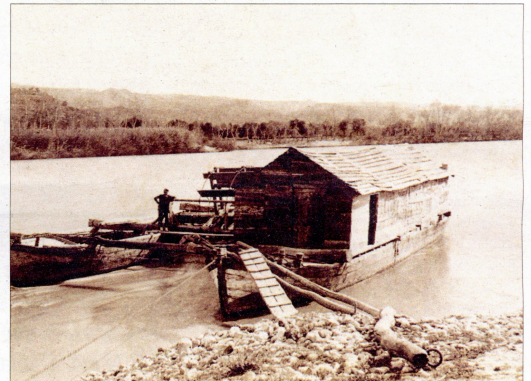
Imatge d'un molí flotant, construït sobre unes embarcacions que aprofitaven el corrent del riu per a fer moure les rodes, d'Aldover. / CEDIDA
