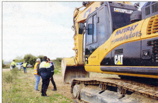
Les màquines comencen a construir el parc eòlic Los Barrancs, a Vilalba.
